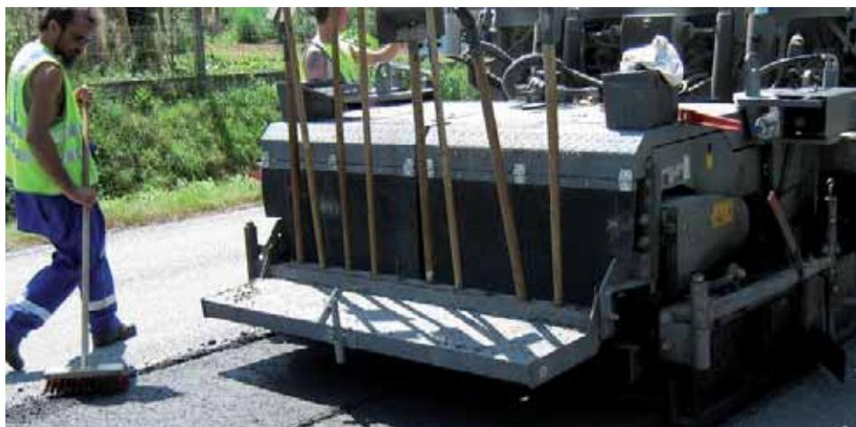
*"Avec le procédé de retraitement en place à froid, le bilan énergétique et écologique s'avère positif."*
