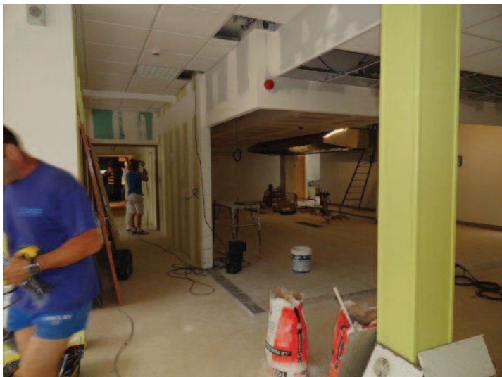
Pendant les travaux ...
