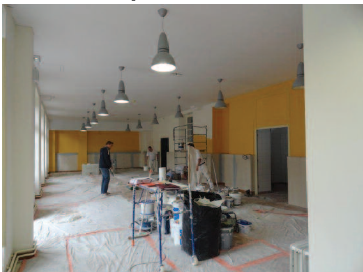
Pendant les travaux ...
