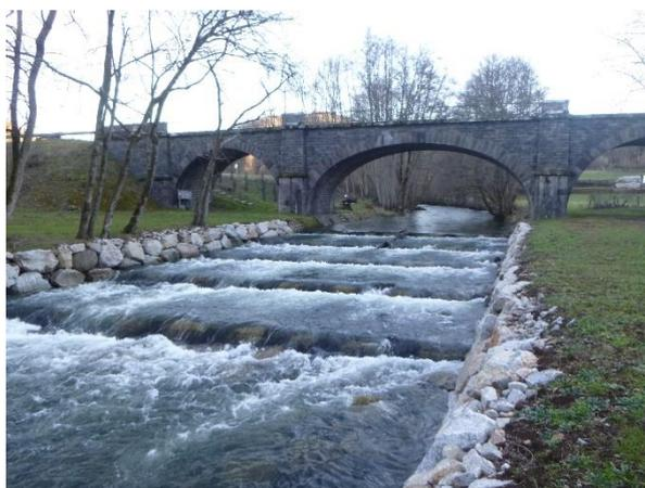
*Photo 1 : Restauration de la continuité écologique sur le Mars par un aménagement en aval du radier par prébarrages (2017)*
