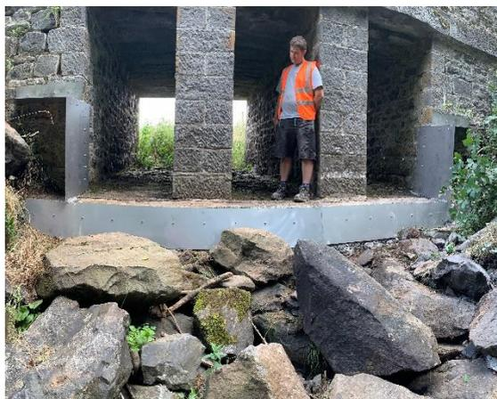
*Photo 2 : Barrette sur un ouvrage pour bloquer la remontée d'écrevisses de Californie sur un affluent de l'Ander (2019)*
