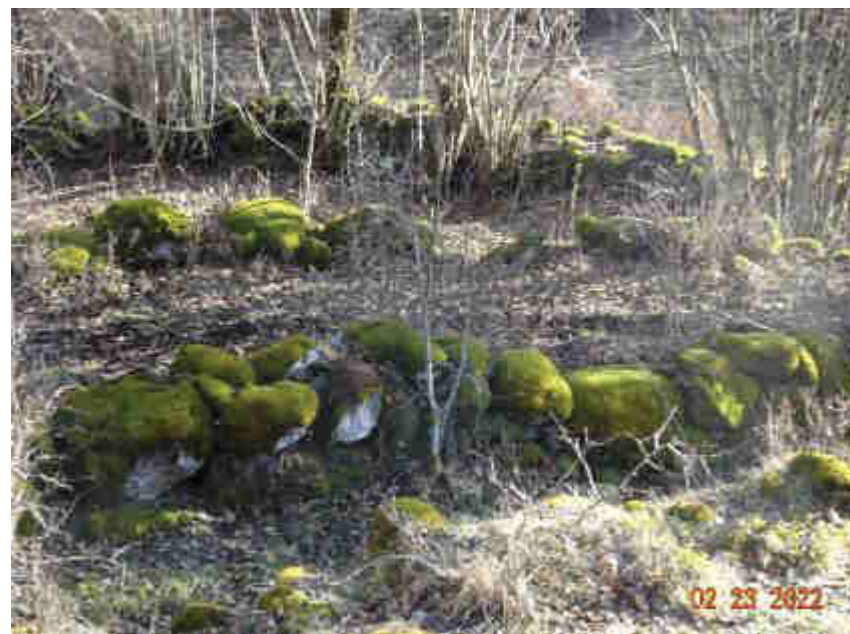
Ci-dessus, succession de talus rapprochés perpendiculaires à la pente doublé d'un empilement de pierres dans le secteur de La Chau.
