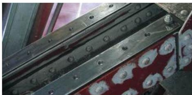
Vue de la réparation d'une diagonale par ajout d'une tôle
