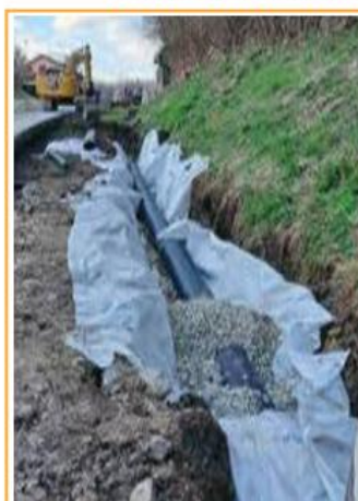
D922 REILHAC : Drainage de la plateforme routière avant élargissement de la chaussée pour construction d'un tourne à gauche
