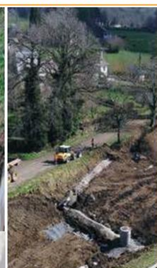
D922 St-CHAMANT : Assainissement de la plateforme
