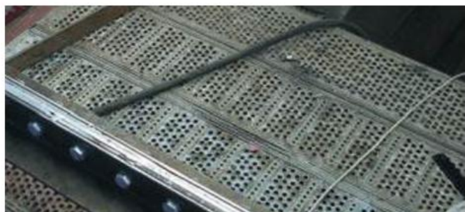
Remplacement de la base du contreventement de la charpente
