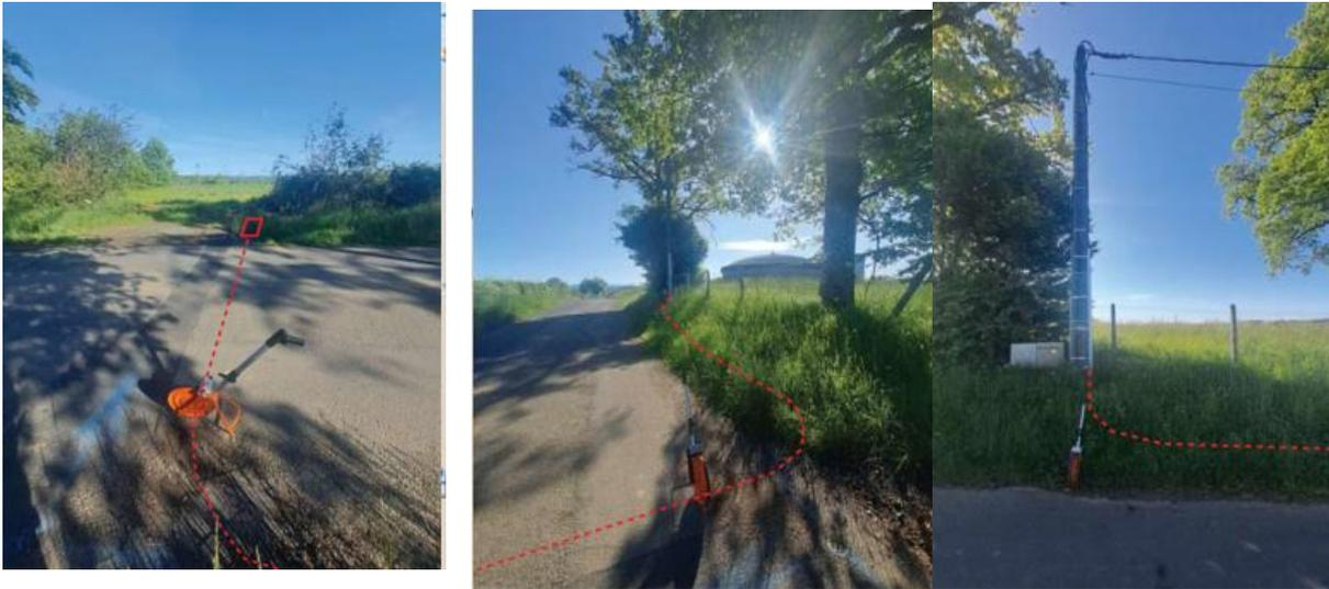
**Schéma n°6-2** tranchée sous accotement située à une distance du bord de chaussée inférieure à 0,75m pour les RD des catégories cat.1, 2 et 3
