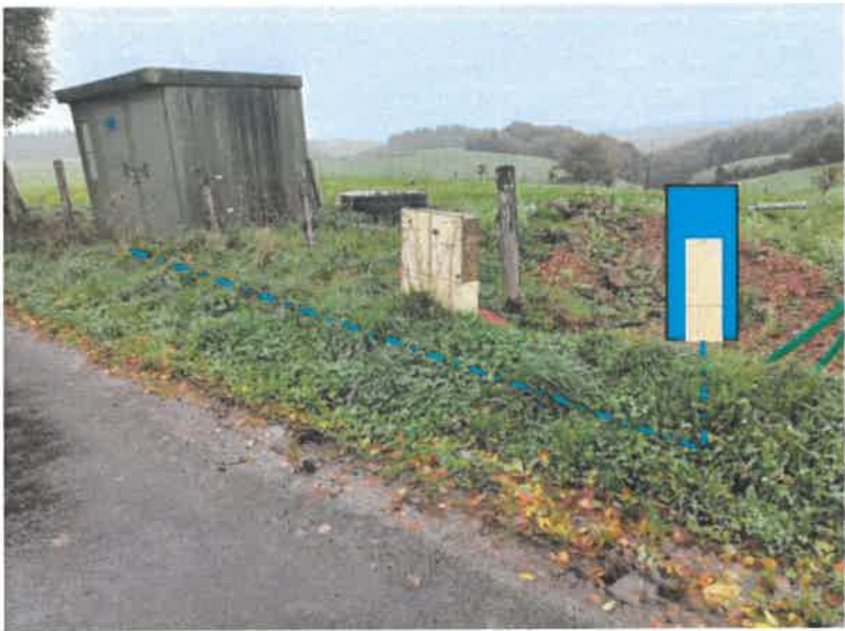
Pose d'un câble BT 240 depuis le poste existant sur 8m, en accotement et pose d'un ECP2D et une armoire C4
