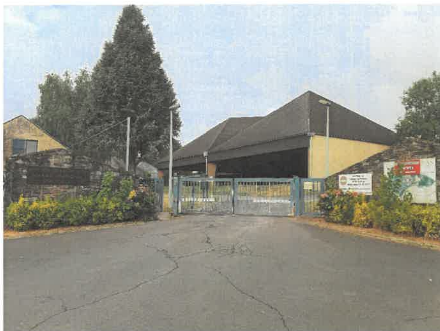
1 – Portail d'accès côté Avenue de Julien
